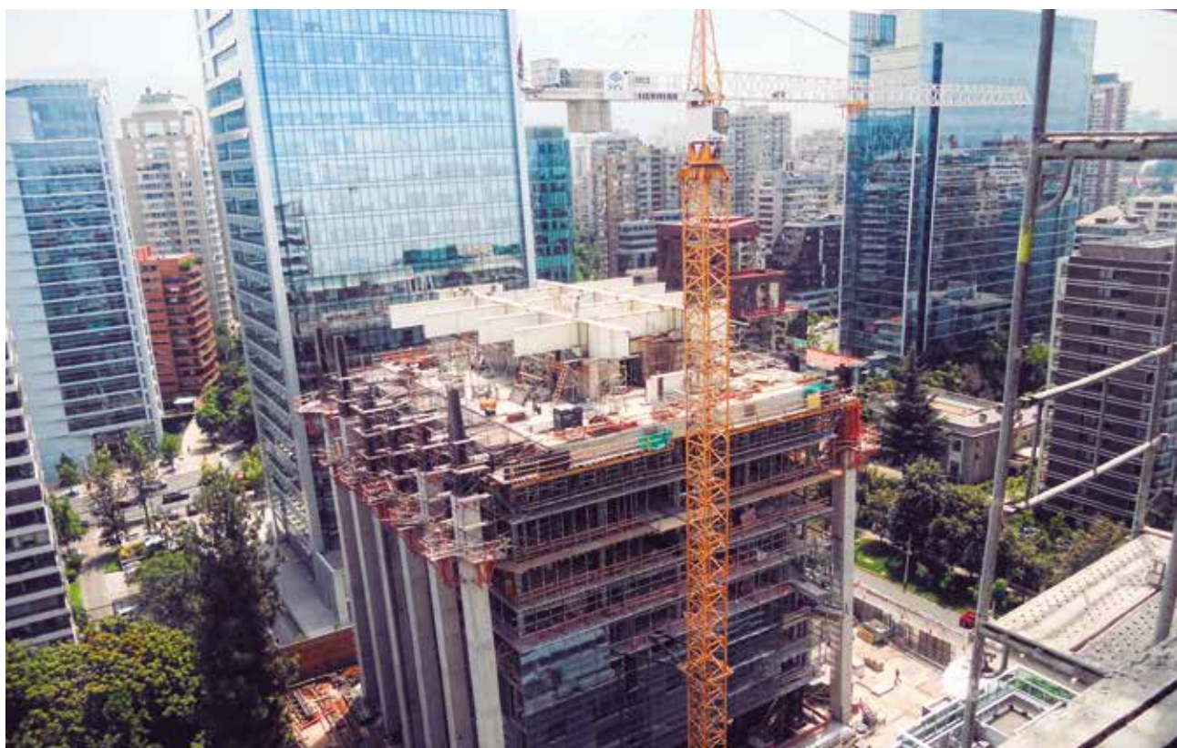
Losa postensada y columnas postensadas edificio Alcántara 99, Santiago - Chile
