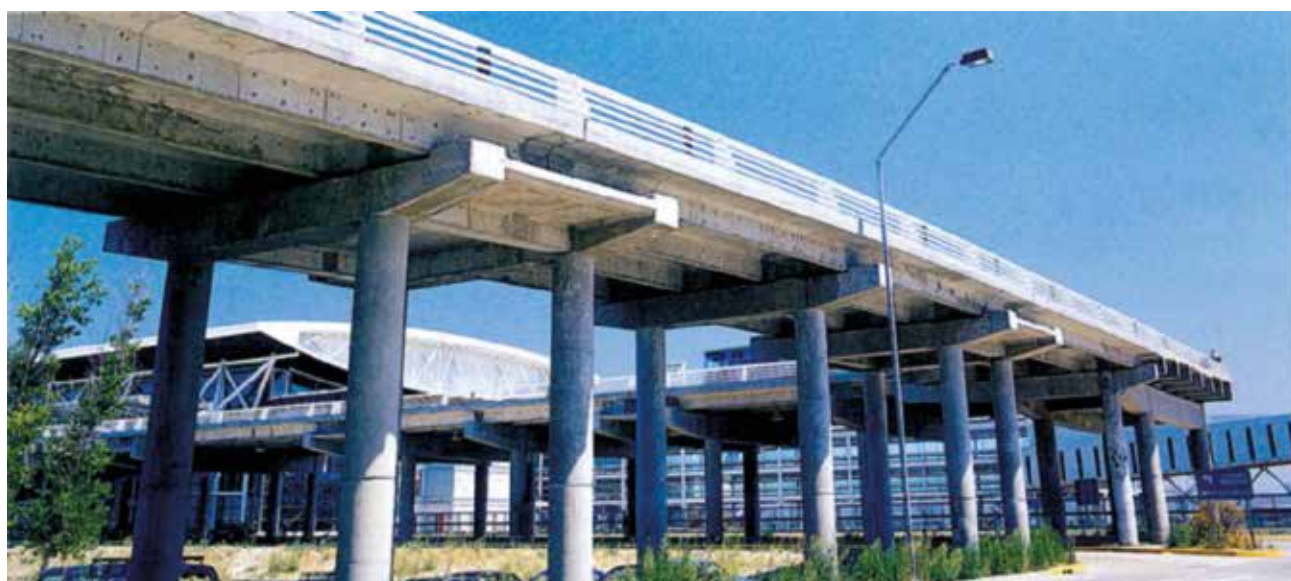
Pilotes aeropuerto de Santiago, Santiago – Chile
