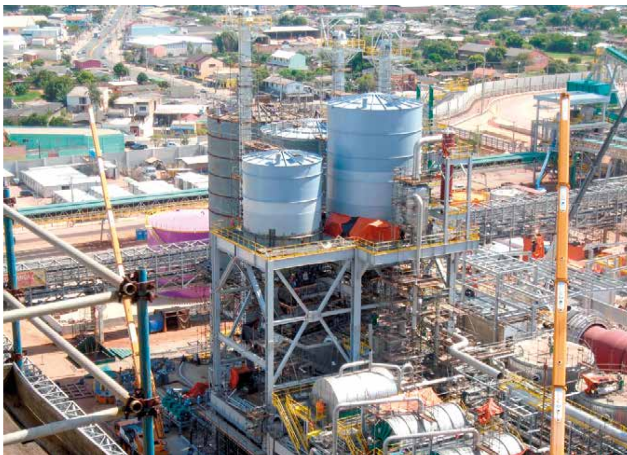
Montaje electromecánico de la planta de caustificación y horno de cal de la celulosa CMPC, Guaíba – Brasil
