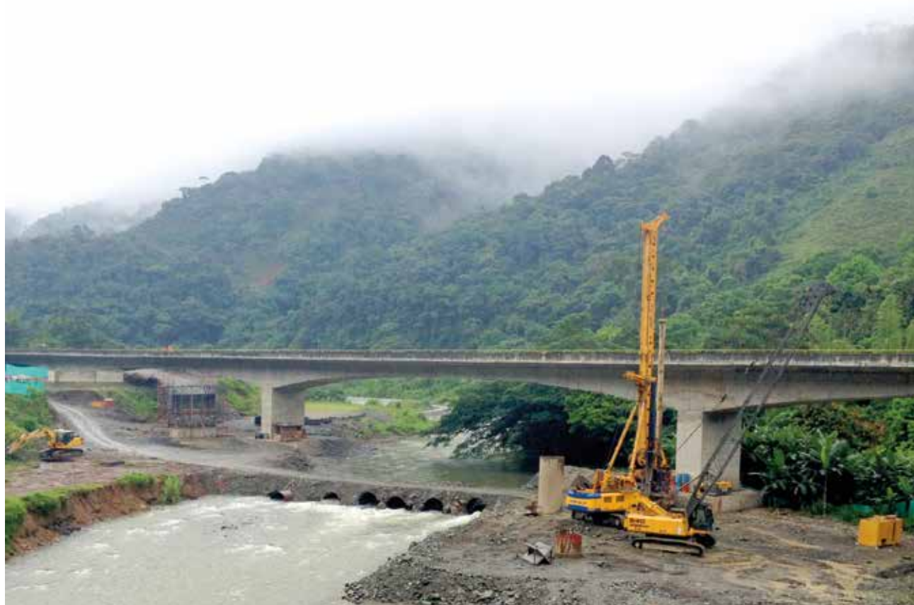
Pilotes Viaducto Buga Buga-Buenaventura, Colombia
